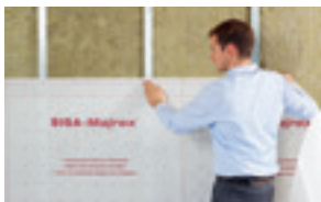
Garų izoliacinio sluoksnio įrengimas ant surenkamų karkasų
