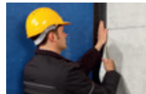
Fasadinės membranos jungtis su mūrinės konstrukcijos siena
